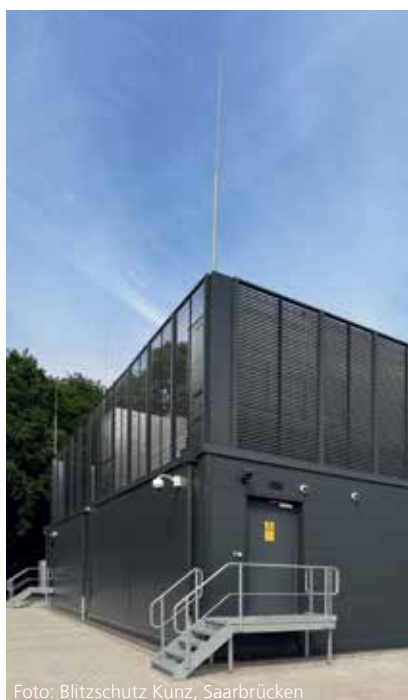
Foto: Blitzschutz Kunz, Saarbrücken
