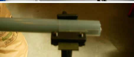
Afisoler hver ledet svarende til presforbinderenes indstiksdybde (+ 5 mm hvis der anvendes matrice og dorn presning).
