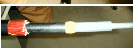
Kanten af det stripbare lag bevikles med gul feltstyrende mastik ca. 10 mm på isolationen og ca. 5 mm på det stripbare lag i en jævn konus form der afsluttes tynd og lige på den rengjorte PEX isolation.
