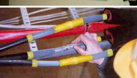
Presforbinderne bevikles med gul mastik SGM 25 til en diameter lidt større end PEX-isolationen og max. 5 mm ind på ledederisolationsen på hver side .
