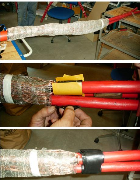
Skærmlægningerne samles med en presforbinder og lægges jævnt fordelt på diameteren i muffsens længde. Cu-nettet vikles om hele splejsningen fra kabelkappekanten på 3-lederkablet til kabelkappekanterne på 1-lederkablerne, hvorved man undgår skarpe spidser m.v.
