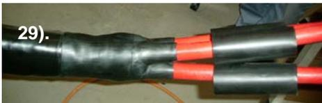
29). Forgreningsformgodset CCB2145 placeres over mastikken og yderkappen og krympes. De tre trykslanger 523-50/17-150 med lim anbringes over forgreningsformgodsets fingre og krympes.
