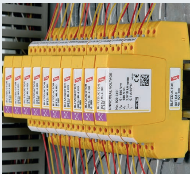
Eksempel på brug af BLITZDUCTOR XTU
